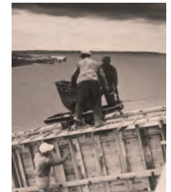
Det var ikke et helt ufarligt arbejde at deltage i indstøbningen af de høje stålbuer på Aggersundbroen. Engang faldt en murer i vandet, uden at han dog kom noget alvorligt til.
