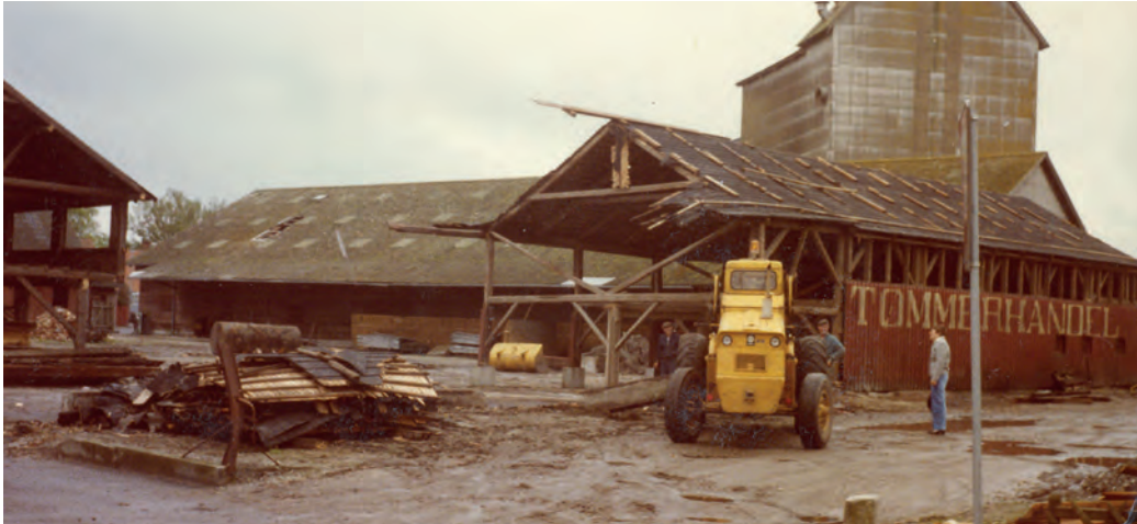
Efter Chr. Olesen & Søns overtagelse af tømmerhandlens bygninger for 1 million kroner i 1983 bliver de gamle trælasthaller brudt ned for at give kunder og leverandører bedre tilkørselsforhold.
