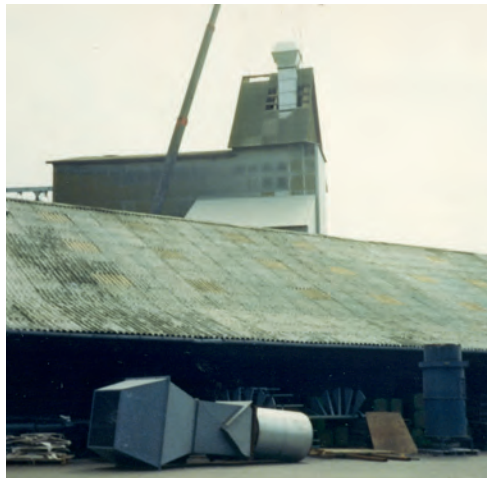
Et stadig stigende flow af korn gennem Chr. Olesen & Søns anlæg betød øgede miljøkrav til virksomheden, blandt med et filter, der skulle rense luften fra korntørringen.
