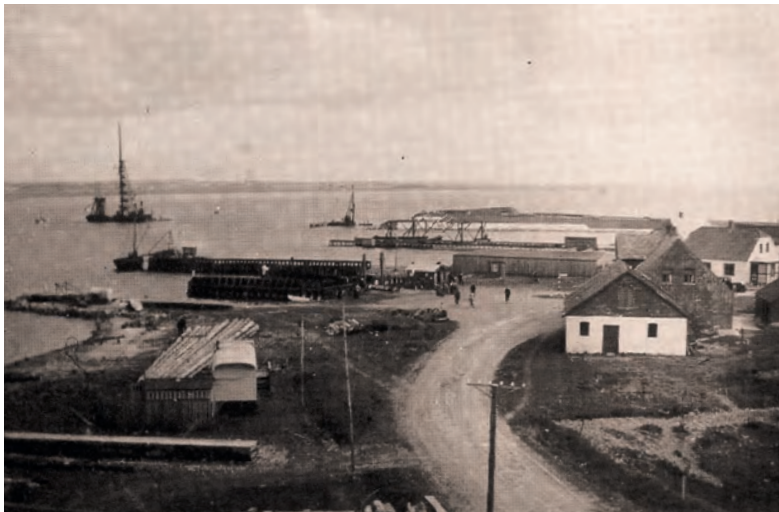
Broselskabets byggeplads i Aggersund Syd.
