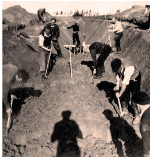
I en stor bue nord om Aggersund blev der udgravet en bred tankspærring – en såkaldt tankgrav – for at hindre de allieredes landgang og fremtrængen med tanks og andet tungt materiel. Arbejderne, der udførte det hårde, manuelle arbejde, kom langvejsfra og blev privat indkvarteret i området.
