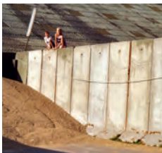
Kraftige betonelementer sikrer adskillelse mellem de forskellige opkøb af korn fra egnens landbrug.
